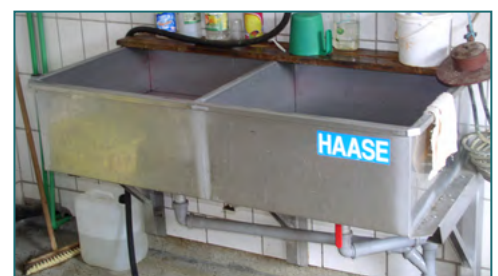
HAASE-Spül- und Desinfektionswanne 555.078 mit Wandhaltern und Waschbeckenablaufgarnitur
