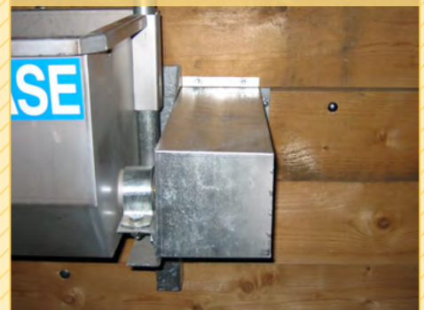
Mögliche Isolierung der Wasserleitung: HAASE-Schutzkasten S. 31
