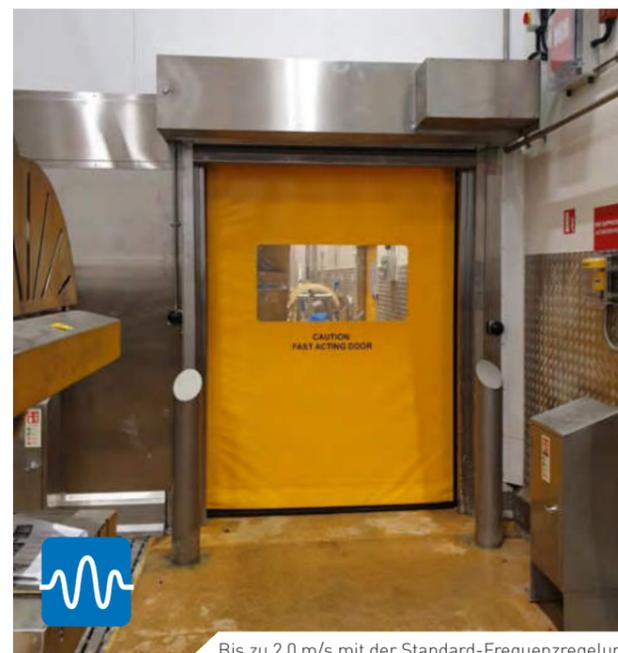
Bis zu 2,0 m/s mit der Standard-Frequenzregelung
