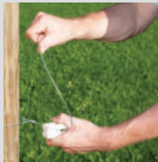
3. Loses Drahtende durch den Zugisolator hindurchführen
