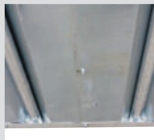
Doppelte Verstärkungsrohre unter dem Bodenblech
