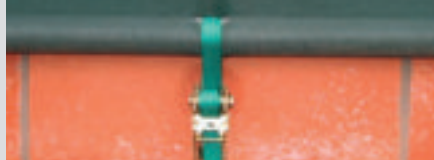
Hohlsaum mit Stahlrohr und Ratsche
