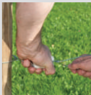
7. Loses Drahtende 5-mal um den Zaundraht wickeln
