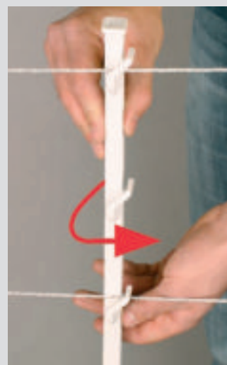
Pfahl um 90° drehen - alle Litzen sind jetzt fixiert - und in den Boden eintreten
