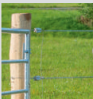
Eckpfosten mit Zugisolatoren und HippoWire
