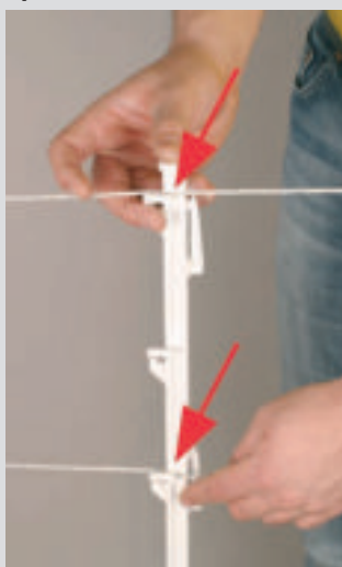
Jeweilige Litze in die entsprechenden Halter einlegen
