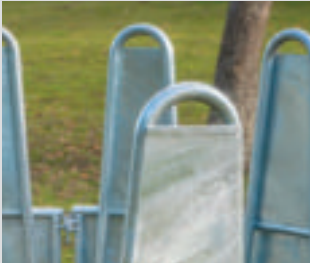
Blechverkleidete Palisadenbögen ohne scharfe Kanten
