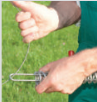
1. Draht in einen Bügel der Feder einführen
