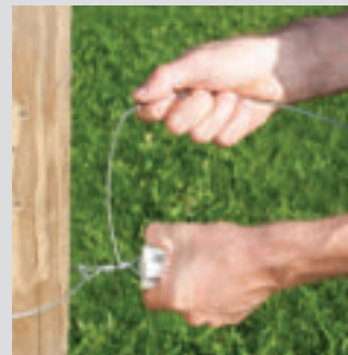
4. Ende 5-mal um den Zugdraht wickeln
