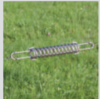
4. Die Befestigung auf der anderen Seite wiederholen und Feder mit dem rotierenden Spanner vorspannen
