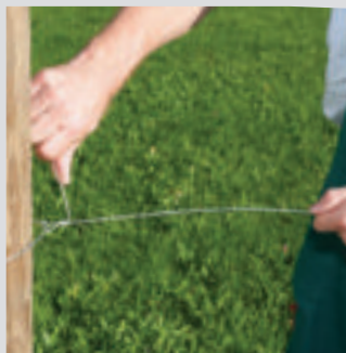
2. Loses Drahtende 3-mal um den Zugdraht wickeln
