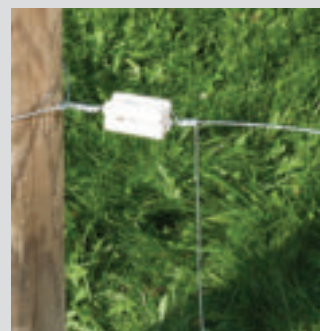
8. Drahtende lang lassen zur Querverbindung
